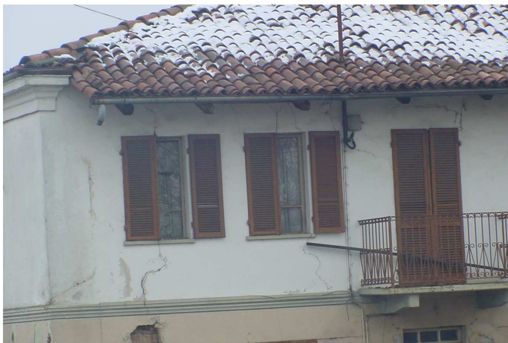
Fotografia B relativa alla proposta di Variante 9 – particolare dello stato fessurativo del fabbricato esistente
